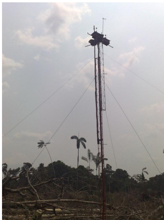
Figura 5 - Torre de coleta de gases montada na área de queima e caixas de proteção térmica com equipamentos.
